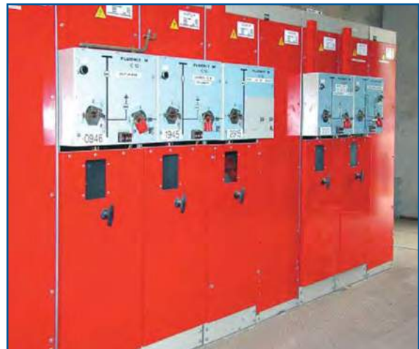
HV Earth Switch Open
